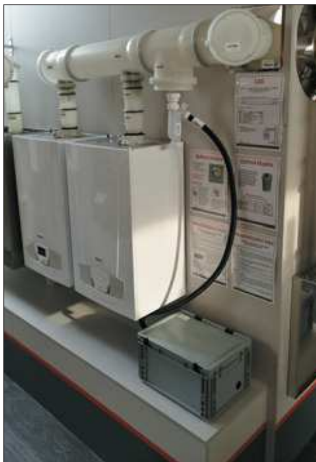
▲ Obr. 2 ● Ukázka zapojení neutralizačního boxu Almeva – napojení pomocí hadice určené k odvodu kondenzátu ze sifonu do předem přichystaného otvoru v neutralizačním boxu
