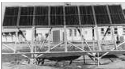
▲ Obr. 3 ● Konstrukce s celoželeznými kolektory byly menší, trvale 45^\circ
