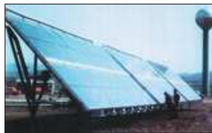
▲ Obr. 1 ● První velká realizace celohliníkových kolektorů v Pliešovcích, kde už typová nosná konstrukce připomínala strom
