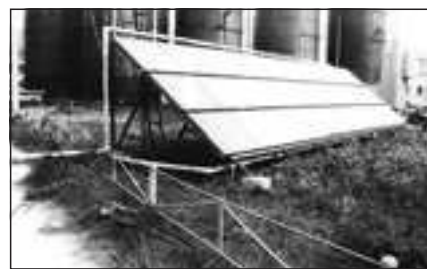
▲ Obr. 3 ● Konstrukce s celoželeznými kolektory byly menší, trvale 45^\circ
