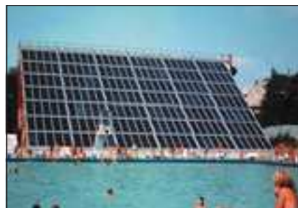
▲ Obr. 11 ● Speciální kombinovaná stavba určená přímo pro bazénovou technologii a kolektorovou střechu, kolektory se tehdy pokládaly přes sebe jako tašky na střeše
