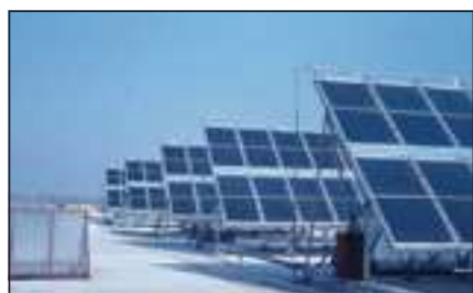
▲ Obr. 5 ● Velké konstrukce na ploché střeše panelárny (teplý beton rychleji tuhne)
