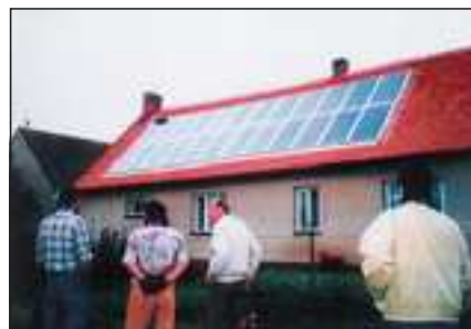
▲ Obr. 10 ● Integrace kolektorů do střechy RD
